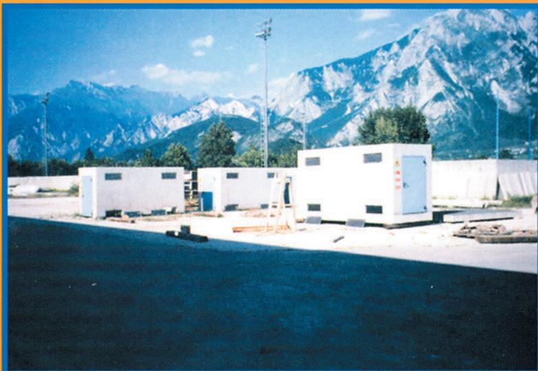
Il **Box Jumbo** è composto da tre elementi prefabbricati in cemento armato vibrato:
